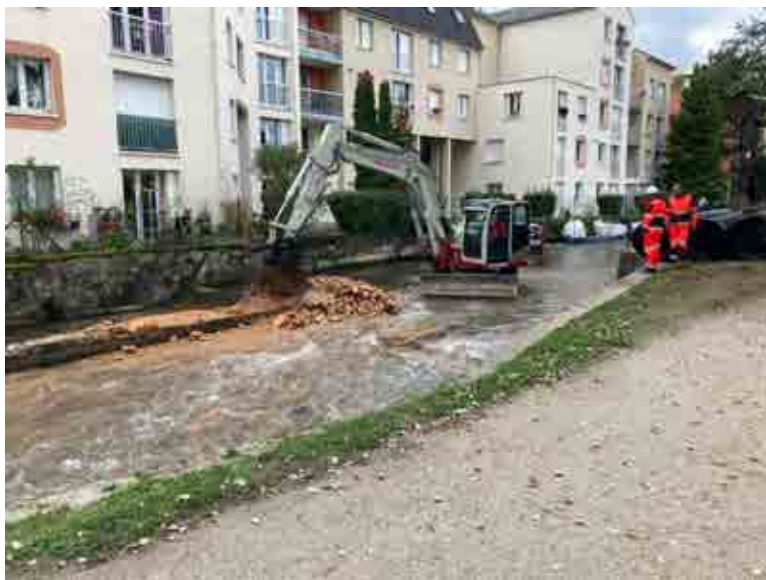
Figure 4 - Travaux du SMABI (Syndicat Mixte d'Aménagement du Bassin de l'Iton) sur la commune d'Évreux : suppression d'un seuil pour restaurer la continuité écologique, permettre le libre écoulement de l'eau et réduire le risque inondation.
