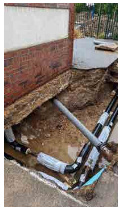
Figure 42 - Observation des réseaux enterrés lors des travaux du système de chaleur urbain - Entrée de la future zone pédagogique
